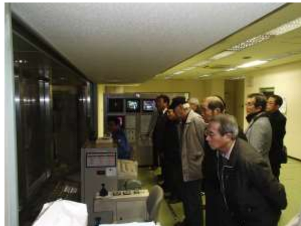
▲ごみ処理場の制御室
