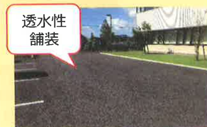
雨水貯留浸透施設（浸透）の事例
