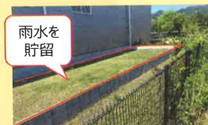
雨水貯留浸透施設（表面貯留）の事例
