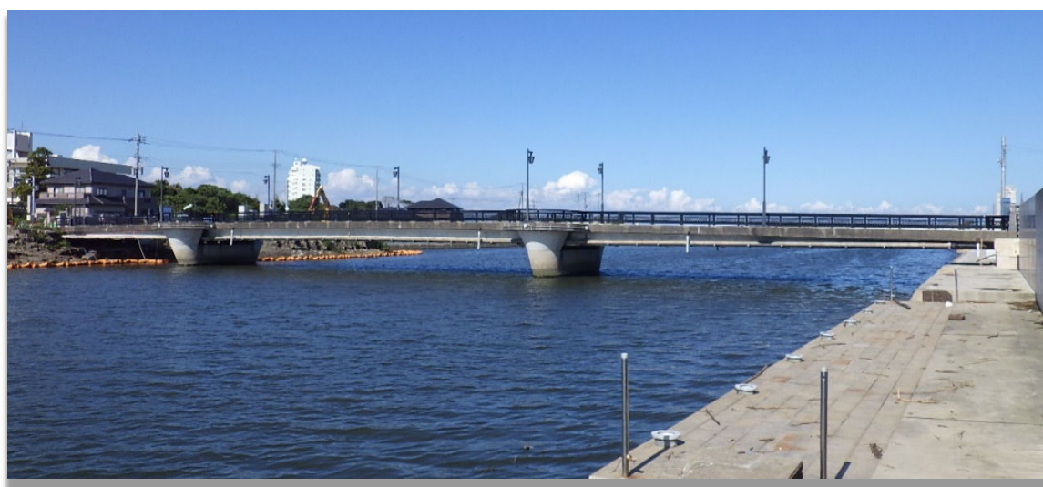
(新一宮橋 撮影：令和4年9月)
